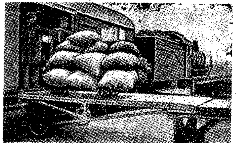
Bild 2. Ausziehbare Laderampe für Leigzüge als Verladeweg vorgezogen
