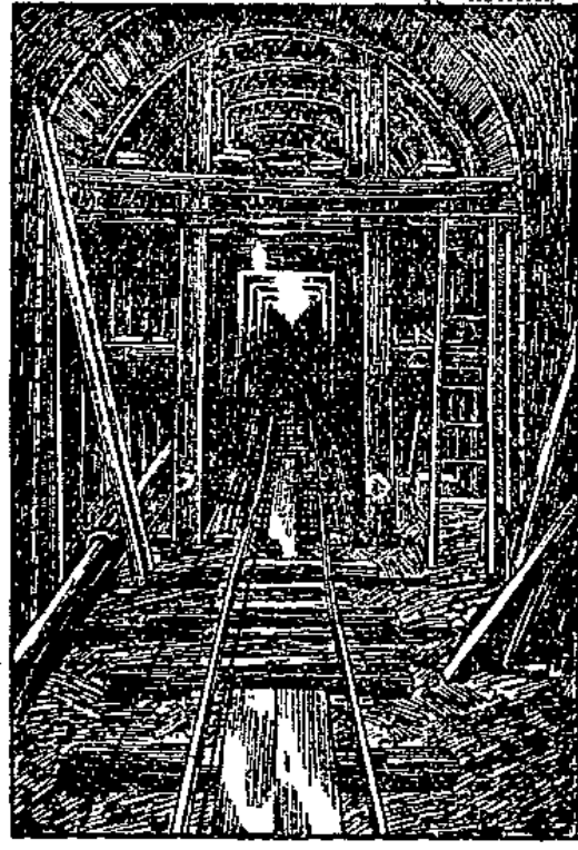
Der Tunnel mußte sicher ausgemauert werden
