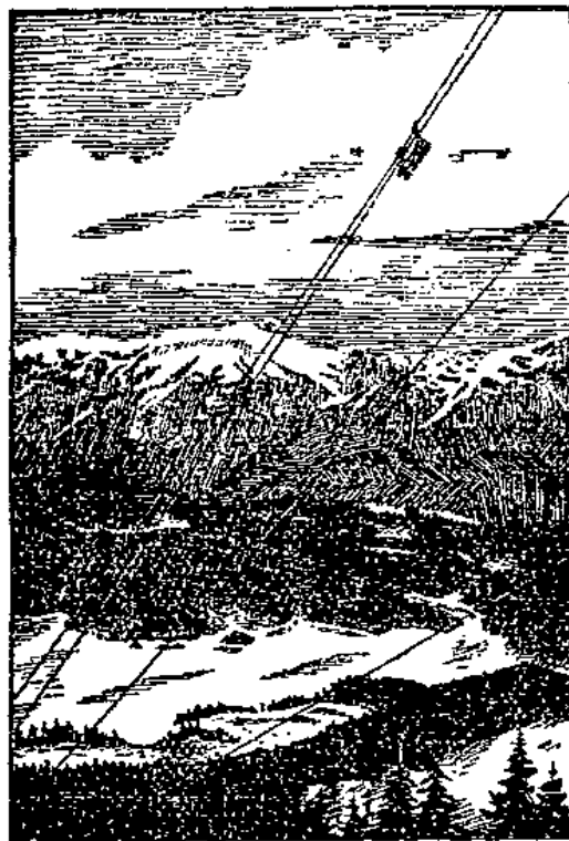
Hilfsseilbahn zu den Fenstern, die von Bergsteigern in gefährlichster Arbeit in den unzugänglichen Abhang geschlagen werden mußten
