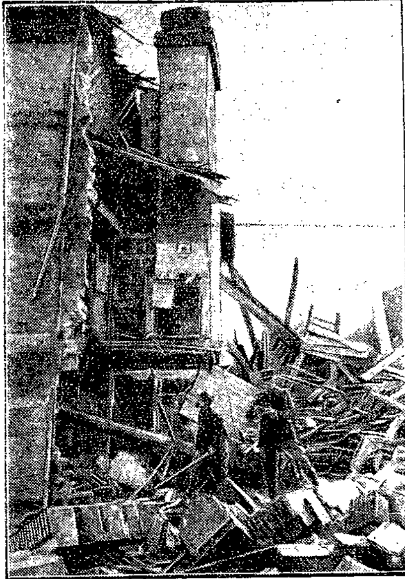
Wie nach einem Erdbeben
