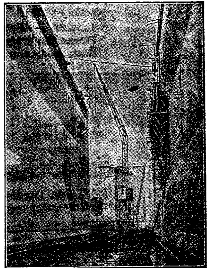
Vom Bau der größten deutschen Seeschleuse
