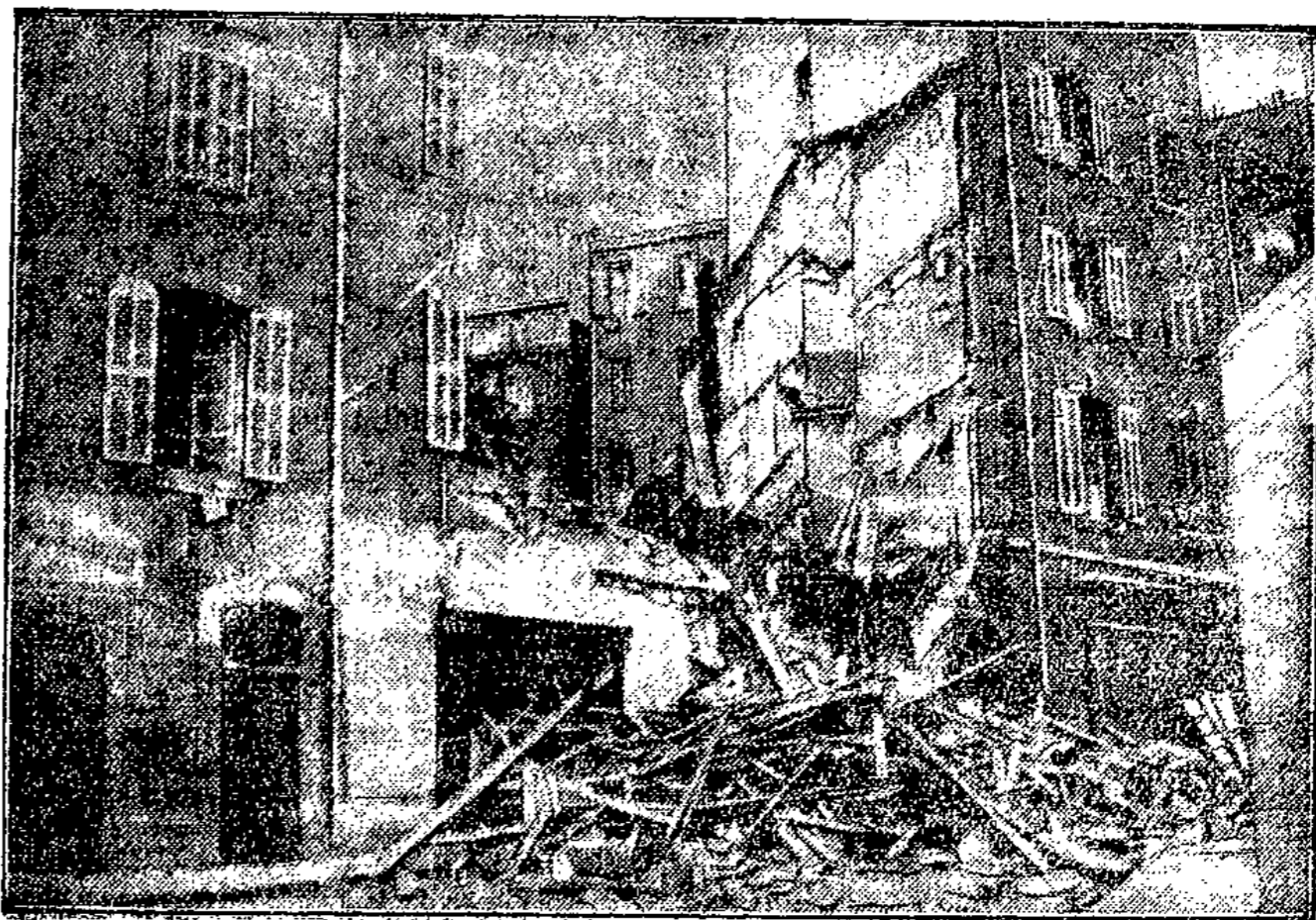
Der Einsturz zweier baufälliger Häuser in Marseille
