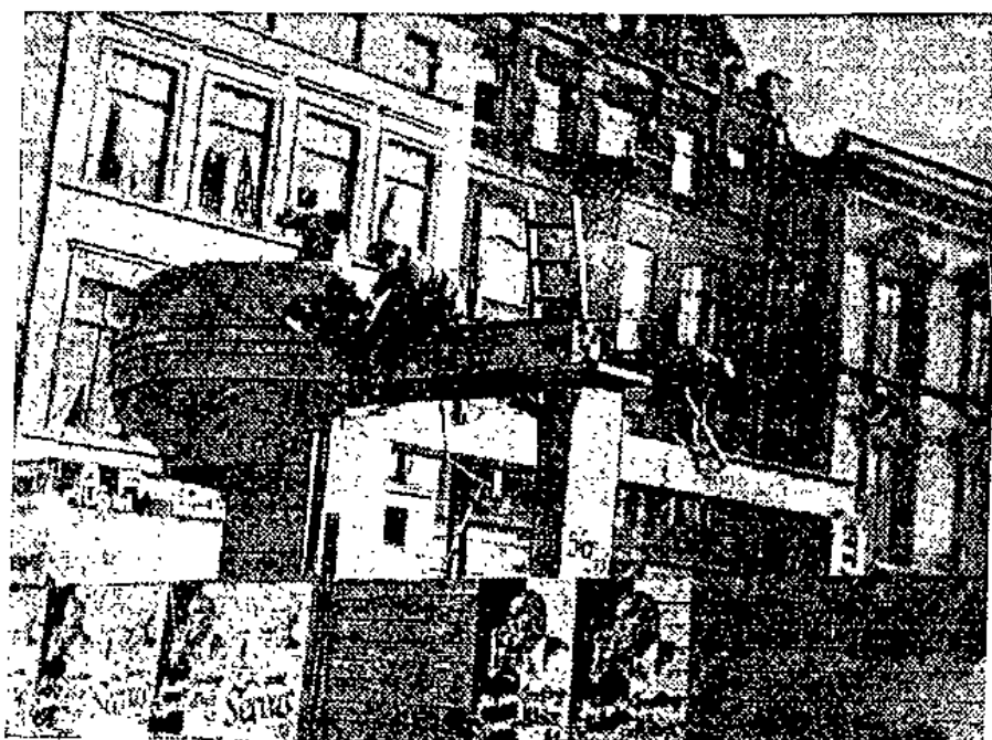
Am Alten Schranken fallen die letzten Säulen
