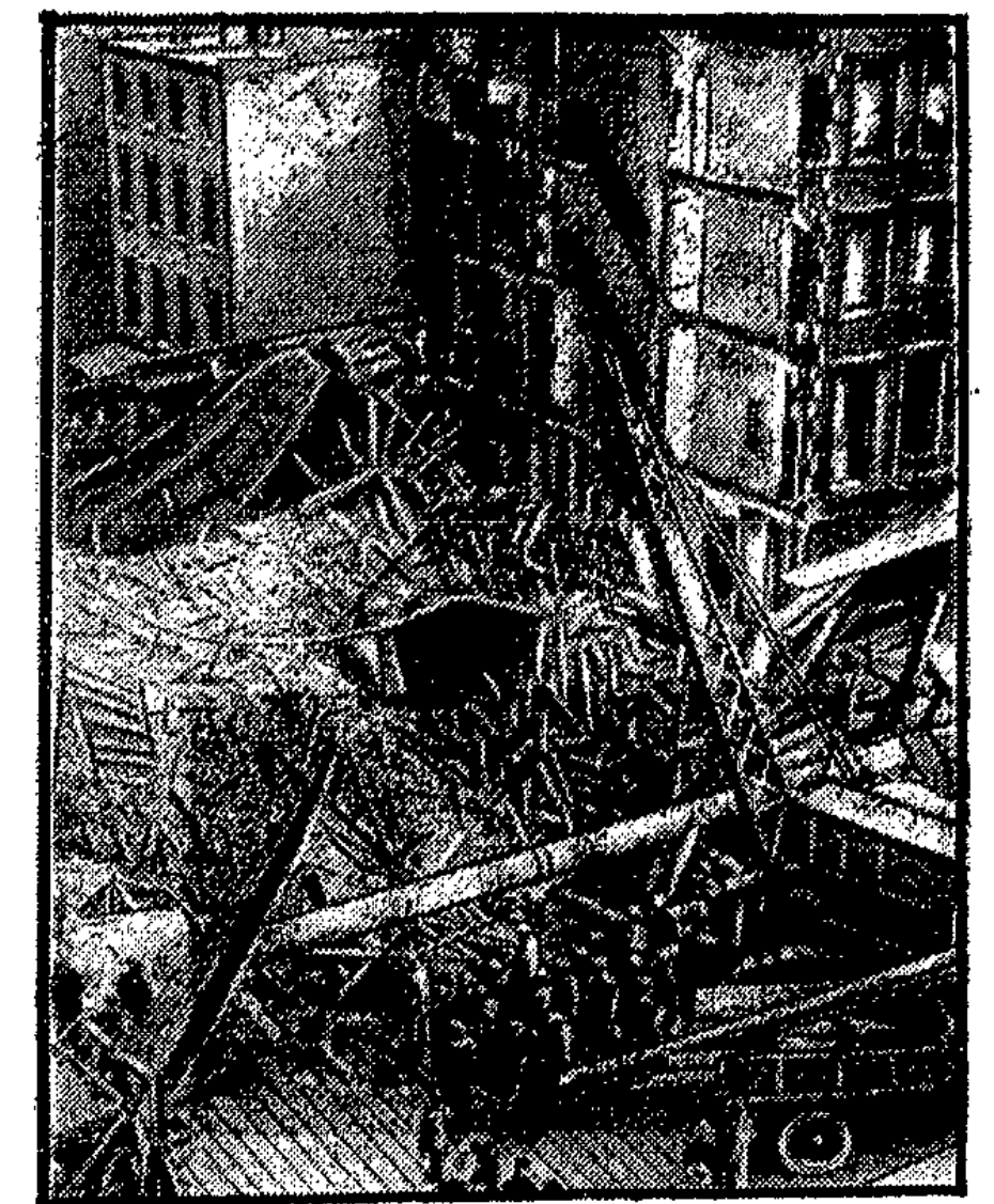
In der New Yorker City stürzten infolge von Bodensenkungen drei vierstöckige Häuser der 8. Avenue ein. Fünf Personen wurden unter den Trümmern begraben. Unser Bild zeigt die Unfallstelle, die stark an die jüngsten Berliner Katastrophen erinnert.
