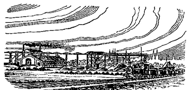
Elektro-Hängebahn mit Brechwerk
