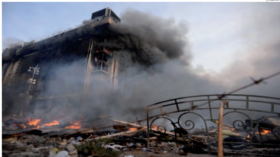
Incendie de la FPU le 21 février 2014.
