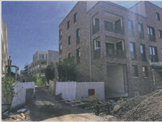
Wohnungsneubau im "Vogelsang": Von ziemlich viel Baustelle...
