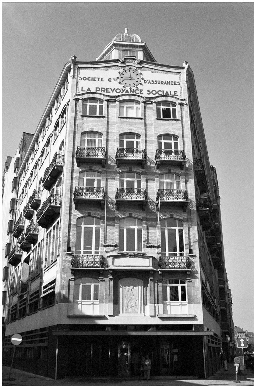
Façade du bâtiment donnant sur le square de l'Aviation.
