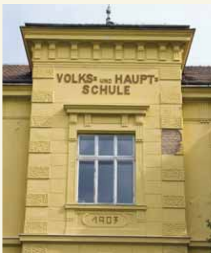
Im Rahmen des Schulsanierungspakets werden bis 2017 rund 570 Millionen Euro für substanzerhaltende Maßnahmen an Wiener Pflichtschulen ausgegeben.
