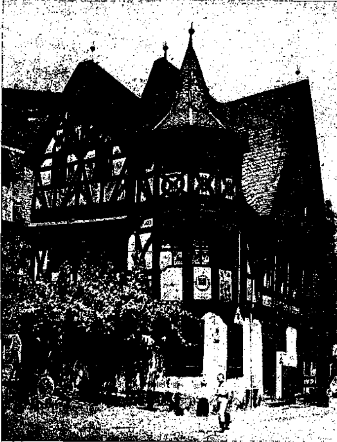
Das alte Haus in Bacharach, der berühmteste Fachwerkbau am Rhein Aufnahme: Jakob Schmitz, Köln
