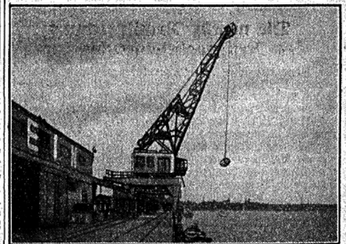
Abb. 3. 5-Tonnen-Halbportal-Wippkran, Ausleger eingezogen, Ausladung 9 Meter.
