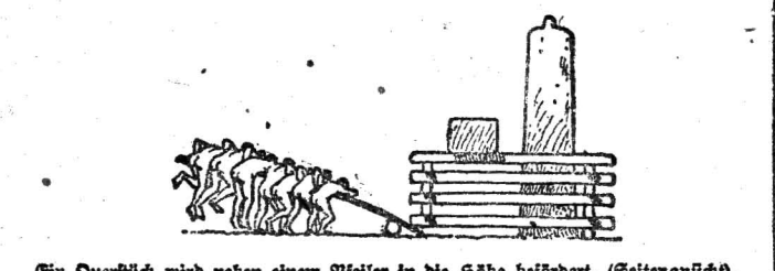
Ein Querstück wird neben einem Pfeiler in die Höhe befördert. (Seitenansicht.)
