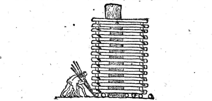
Das Querstück wird auf dem Holzstoß über den Pfeiler geschoben (Seitenansicht).
