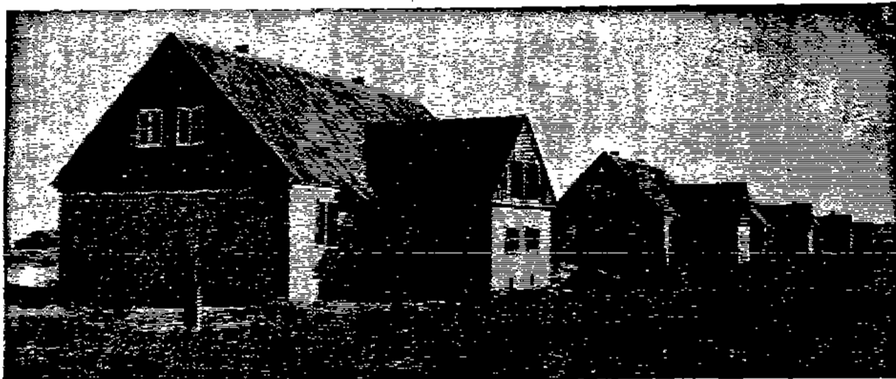
Aus der Kurzarbeitersiedlung Staaken bei Spandau der Siemensfirmen, die zur Zeit im Bau ist Architekt: Dr.-Ing. e. h. Hans Hertlein
