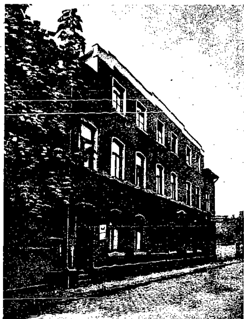
Verbandshaus Duisburg, Pulverweg 11
