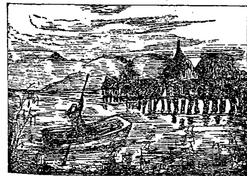
Bild 1: Einbaum zur Zeit der Pfahlbauten.
