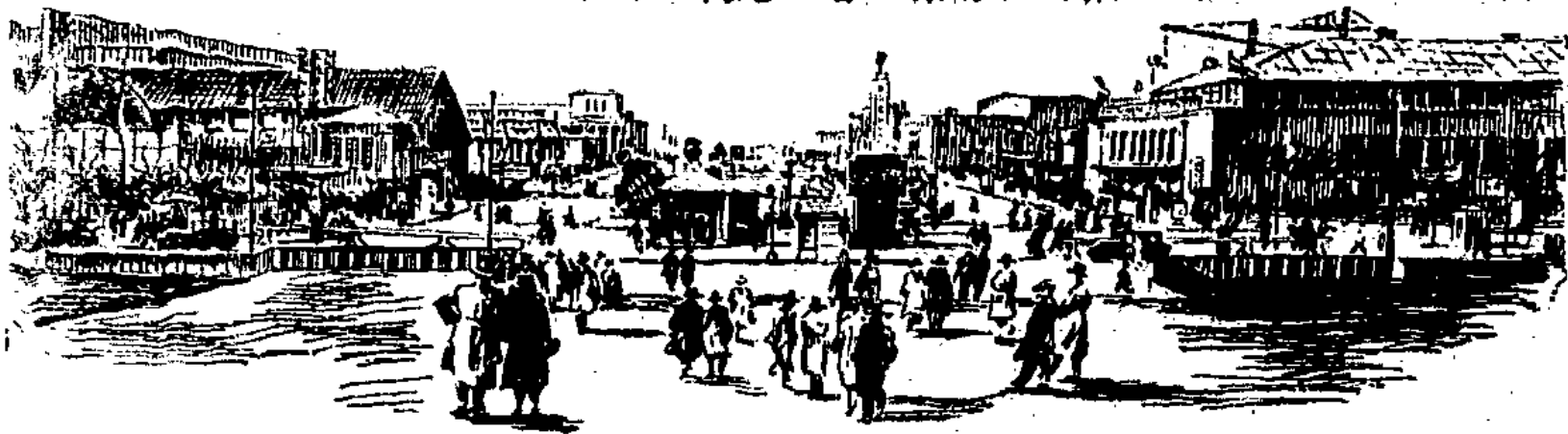
Technische Messe. 16 Hallen für die Ausstellungen der deutschen Maschinen- und Bauindustrie.
