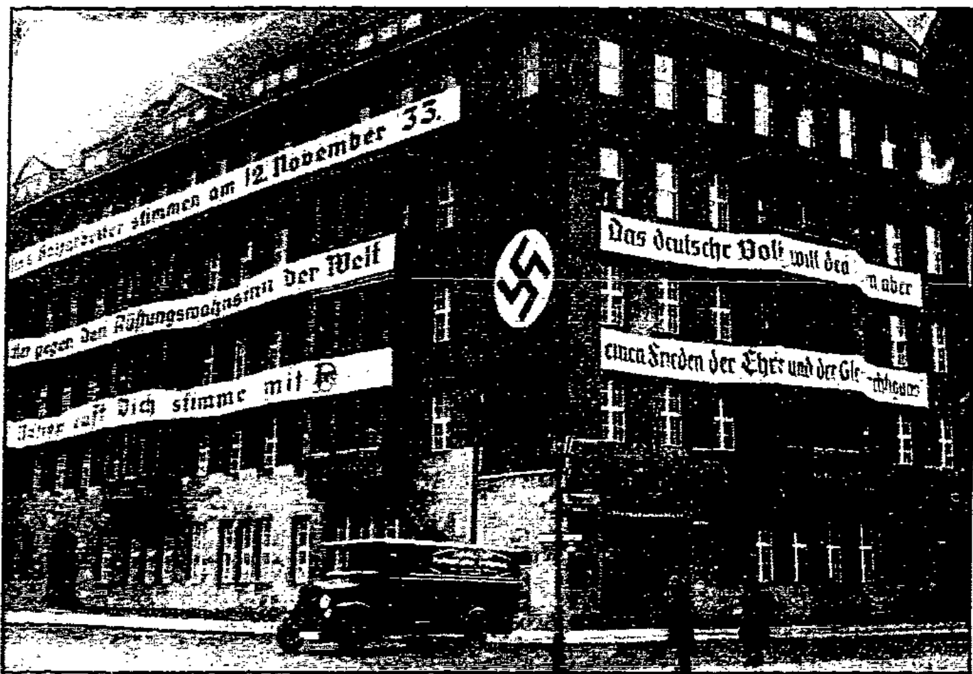
Das Haus des Deutschen Holzarbeiter-Verbandes: Gesamtansicht
