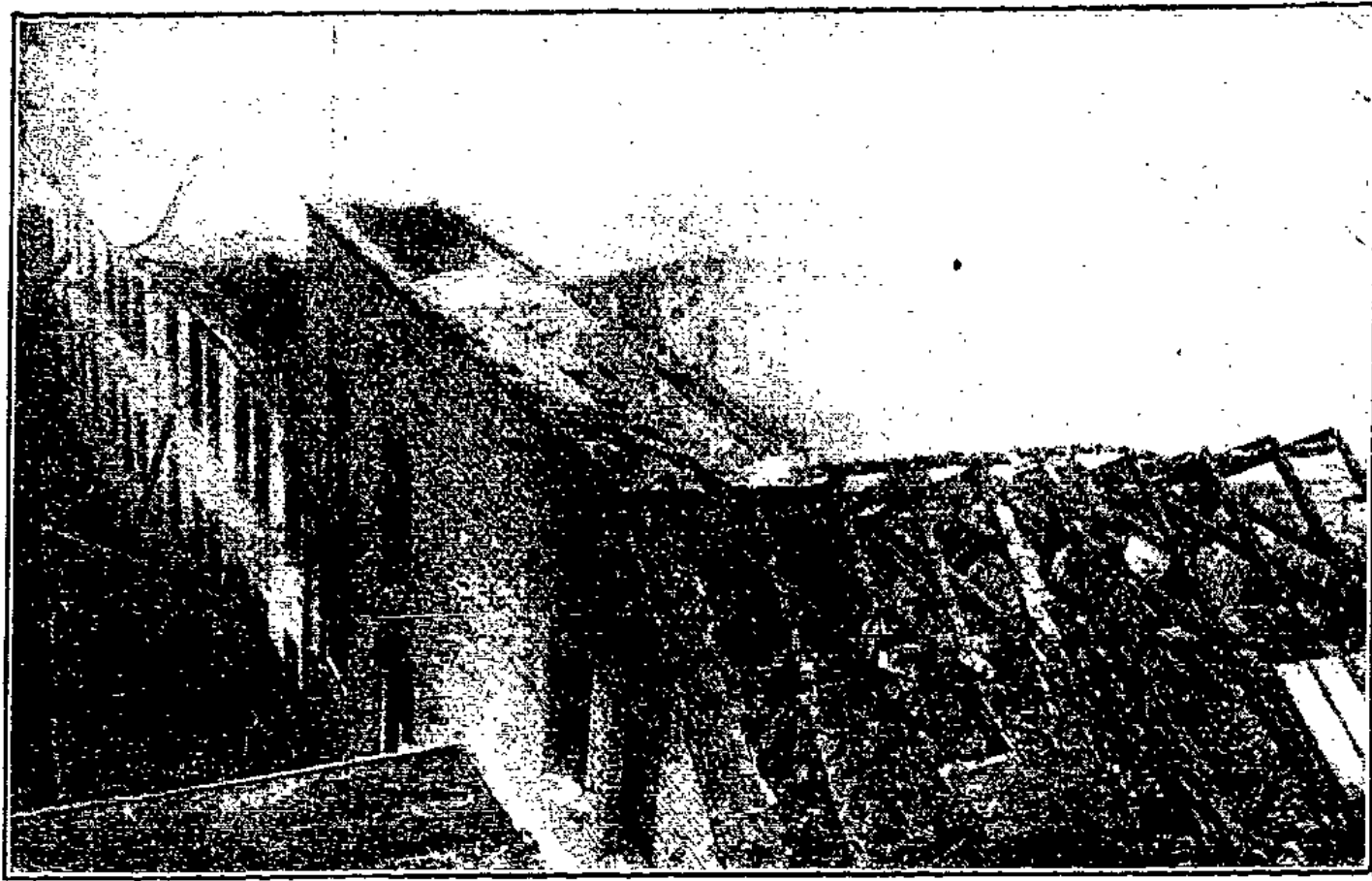
Gesamtansicht der Brandstätte
