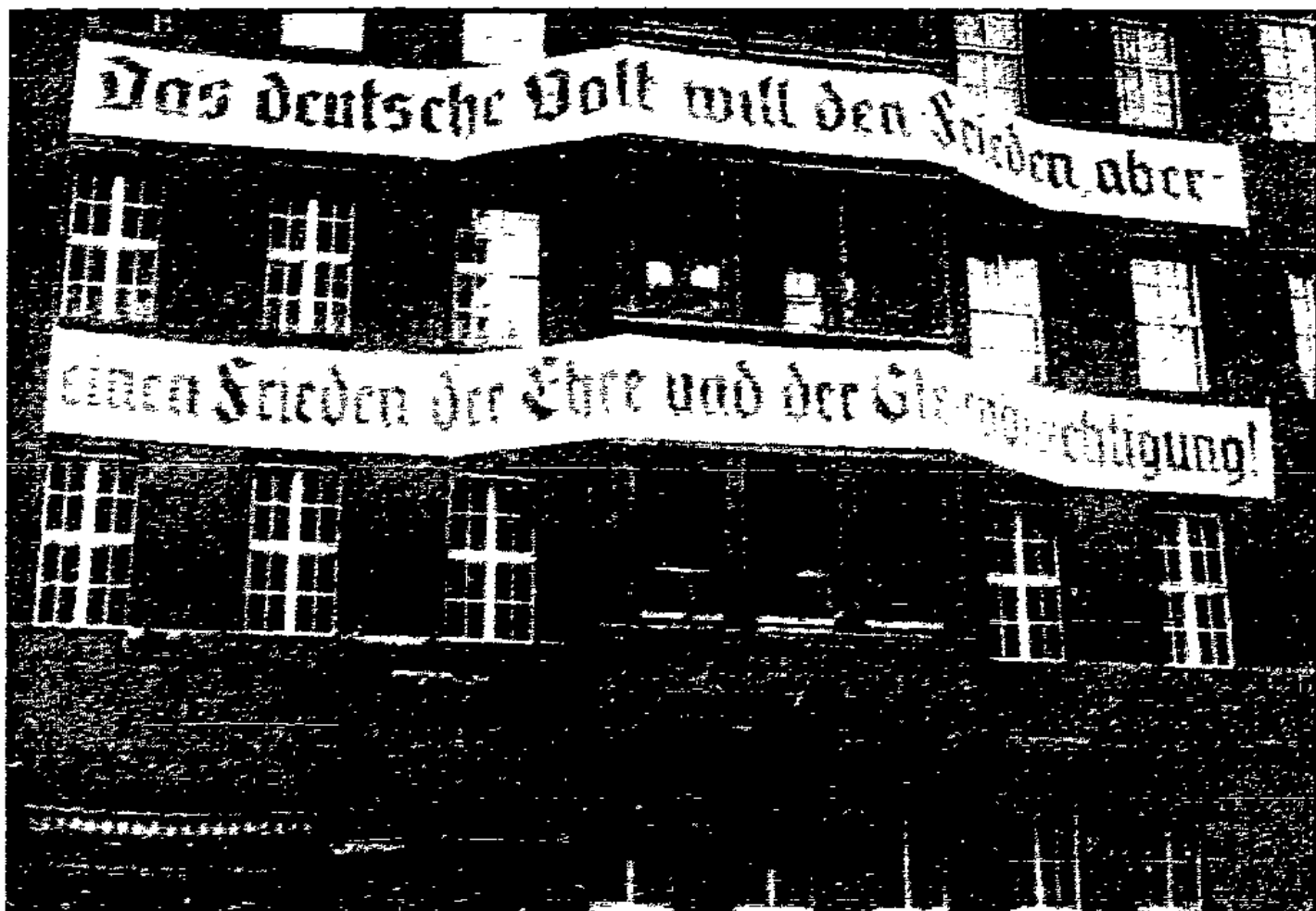
Das Verbandshaus, von der Ringelstraße aus gesehen
