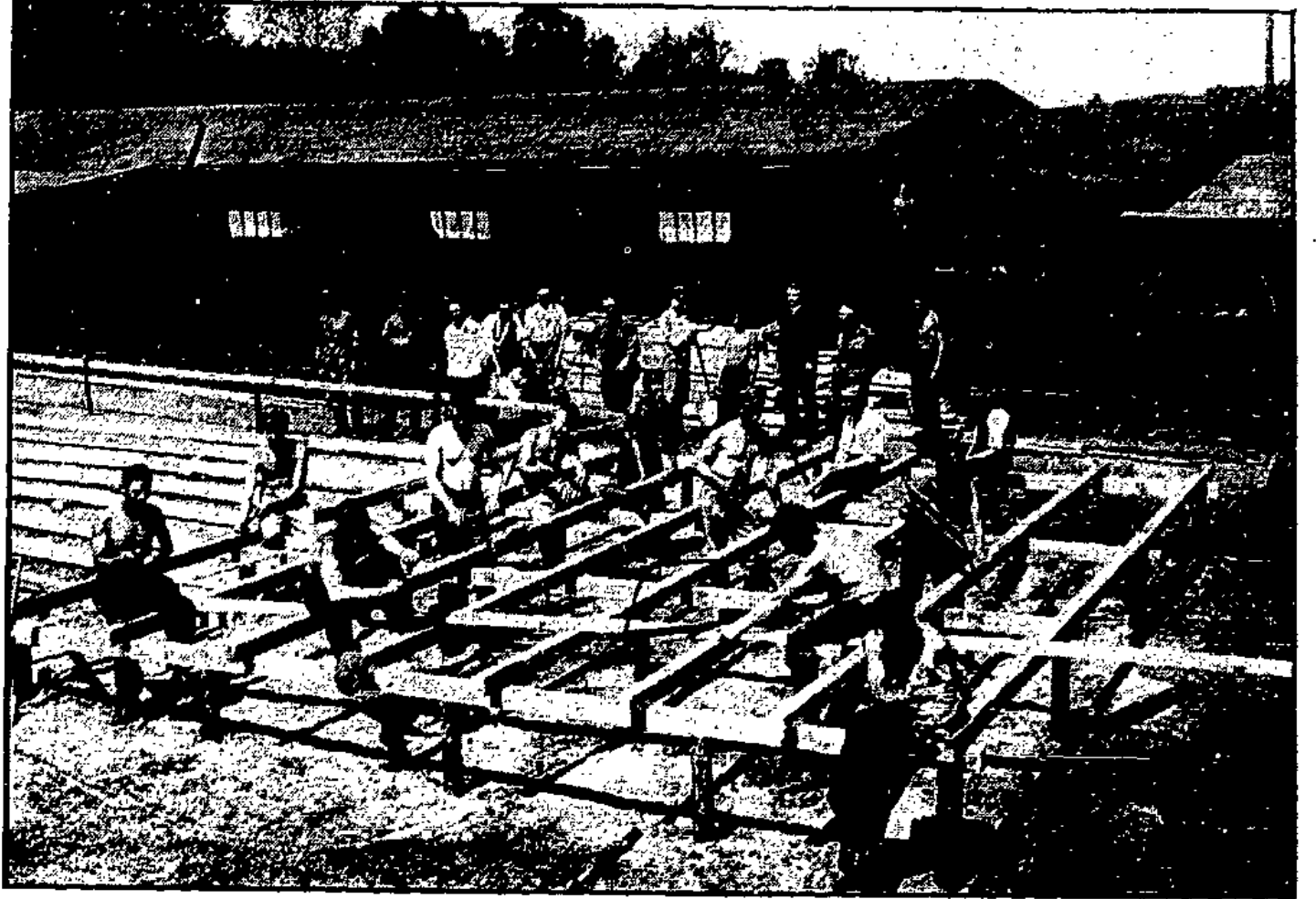
Bau des Arbeitsdienstlagers in Lindau
