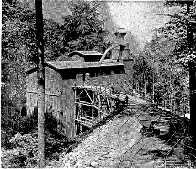
Schotterwerk, vom Schrägaufzug für Rohgesteinzufuhr aus gesehen.
