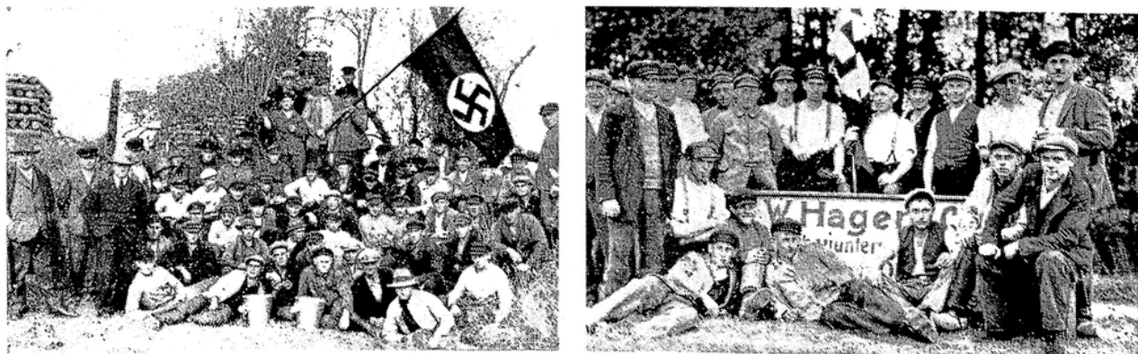
Die beiden Aufnahmen zeigen die Belegschaft einer Baustelle in M e h r o p a, die restlos in unserem Verband organisiert ist
