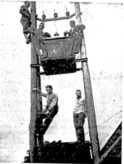
Umbau der Hochspannung zur Landsiedlung Baumgarten
