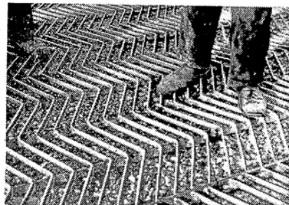
Stahlrost auf der Schotter-Unterlage.
