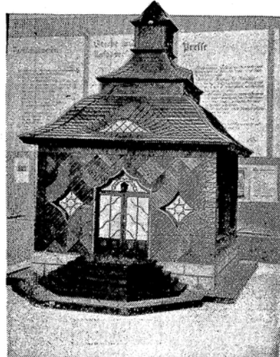
Gartenhäuschen, mit deutschen Schuppenschablonen gedeckt. (Modell auf dem Stand des Reichsverbandes des Deutschen Dachdeckerhandwerks.)
