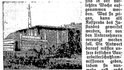
aufpassen und alle derartigen Verstöße der Baupolizei anzeigen.
