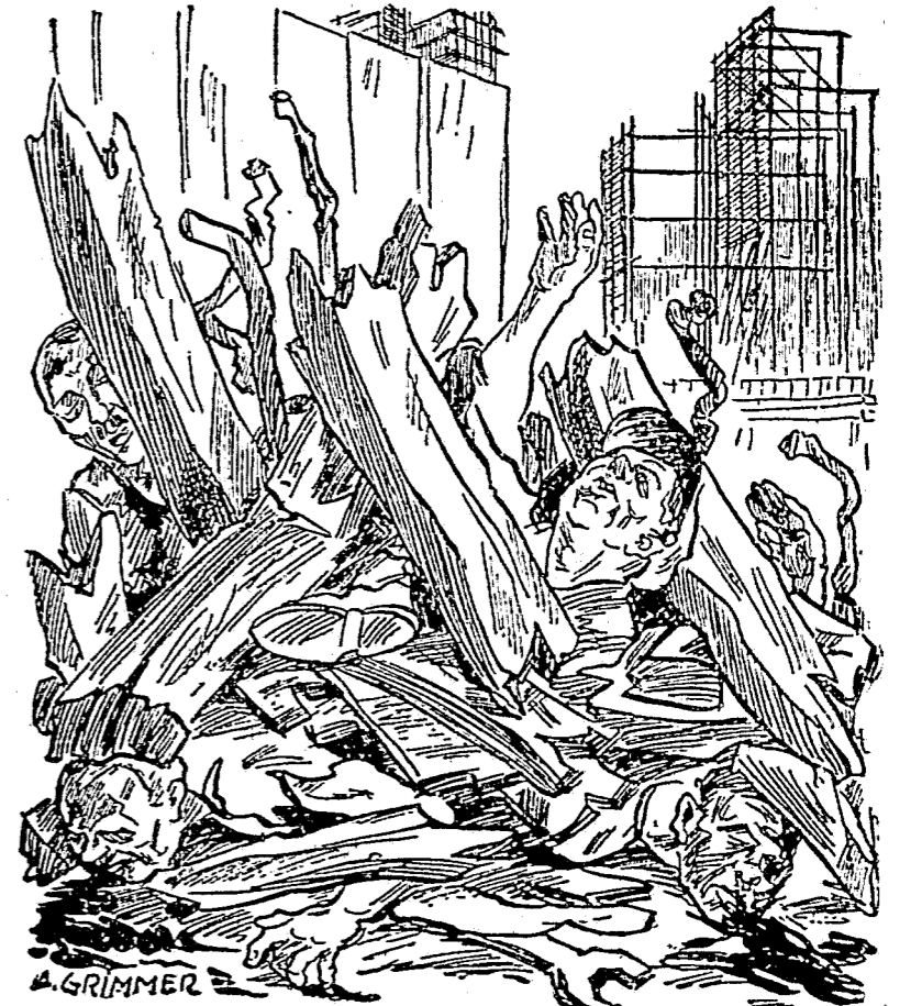
Ein Loter und fünf Schwerverletzte an einem Arbeitstage auf einer Baustelle.
