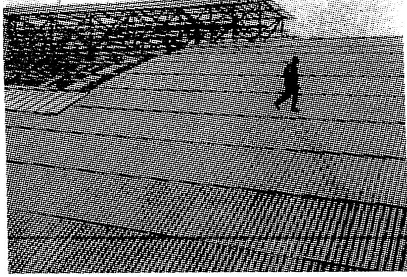
Asbestzement-Wellplatten 250x98 cm x 6 mm, Wellenlänge 177 mm, Wellenhöhe 51 mm, Ueberdeckung horizontal 1/2 Welle, verhält 25 cm. gelöst, daß er eine weiche flockige Form annimmt. Er wird in dieser Form in besonderen Kammern zur Fabrikation bereitgestellt. In besonders geeigneten Mischern werden die Rohmaterialien Asbest und Zement etwa im Mischungsverhältnis 1:6 bis 7 unter Beigabe von Wasser gemischt, bis das Gemisch etwa die Festigkeit eines flüssigen Gußbetons annimmt. Wenn gewünscht kann den Mischern auch eine eisenoxydrote Farbe oder schwarze Rußfarbe beigegeben werden. Das Gemisch selbst wird in tiefer gelegene Rührbockste abgelaufen, die die Funktion eines Puffers übernehmen und durch Schöpfräder eine gleichmäßige Aufgabe auf die Asbestzement-Maschinen bewerkstelligen.
