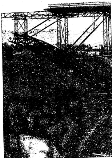
Der reststehende Teil des Bogens.
