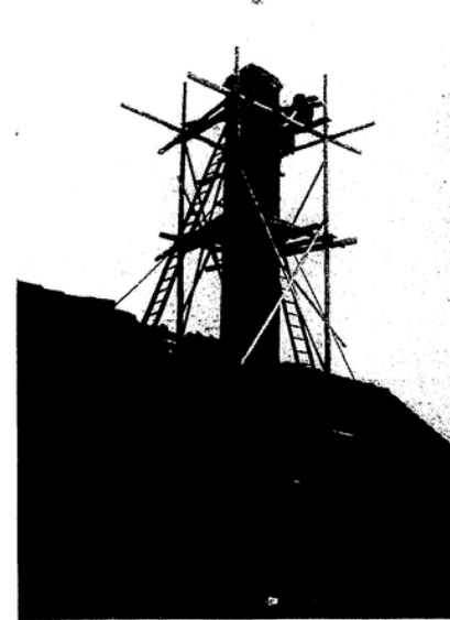
solche Gerüstart gänzlich verworfen werden. Auch dann, wenn vom Bauauftraggeber auf eine möglichst billige Arbeitsmethode gedrängt wird. „Schuster bleib bei deinem Leisten“ hätte dem Bäckereimeister gesagt werden müssen! Nach dem Unfall ist daran, wie aus dem zweiten Bilde zu ersehen ist, ein Stangengerüst errichtet worden, das allerdings noch keineswegs vorbildlich ist. Daß aber nachher der Bäckereimeister sich noch weigerte, die Kosten für das Stangengerüst sowie die Kosten für die Instandsetzung des vom Verunglückten zerstörten Daches zu tragen, zeugt von einer ungemwöhnlich bornierten „Menschenfreundlichkeit“. Also auch bei Reparaturarbeiten von nur kurzer Zeitdauer, sichere und feste Gerüste bauen!
