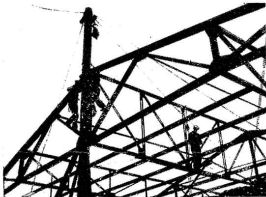
Bild 3: Zusammenfügen von Laststeinen. Eine Abdeckung unterhalb der Arbeitsteile fehlt, obwohl sie leicht herzustellen ist.
