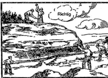
Größte Vorsicht beim Abtragen steiler Wände
