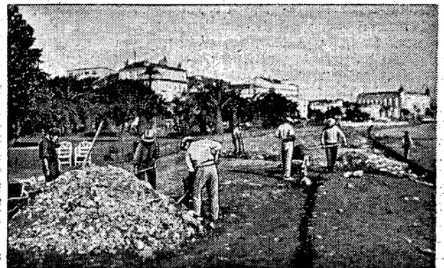
Reparaturen an der Strandpromenade
