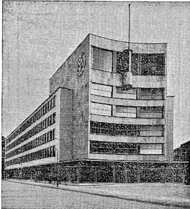
Neues Verbandshaus der Metallarbeiter in Berlin
