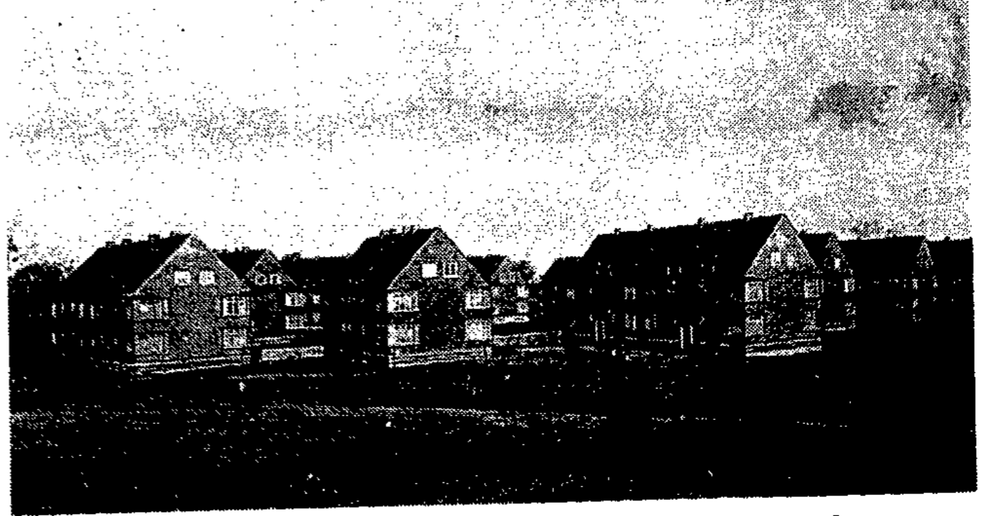
Siedlung Sachsenhof in Suderwich, erbaut 1928-29.
