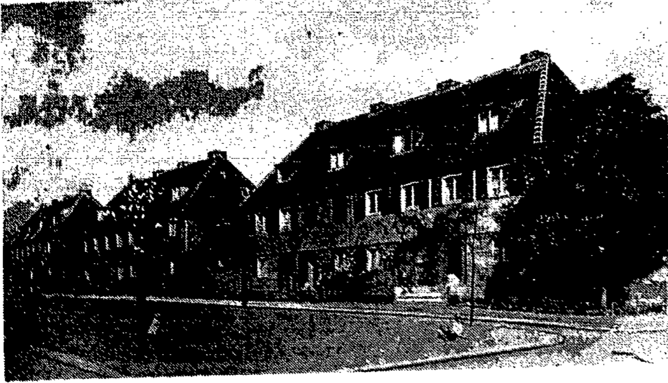
Siedlung in Dorstfeld, erbaut 1920-21.
