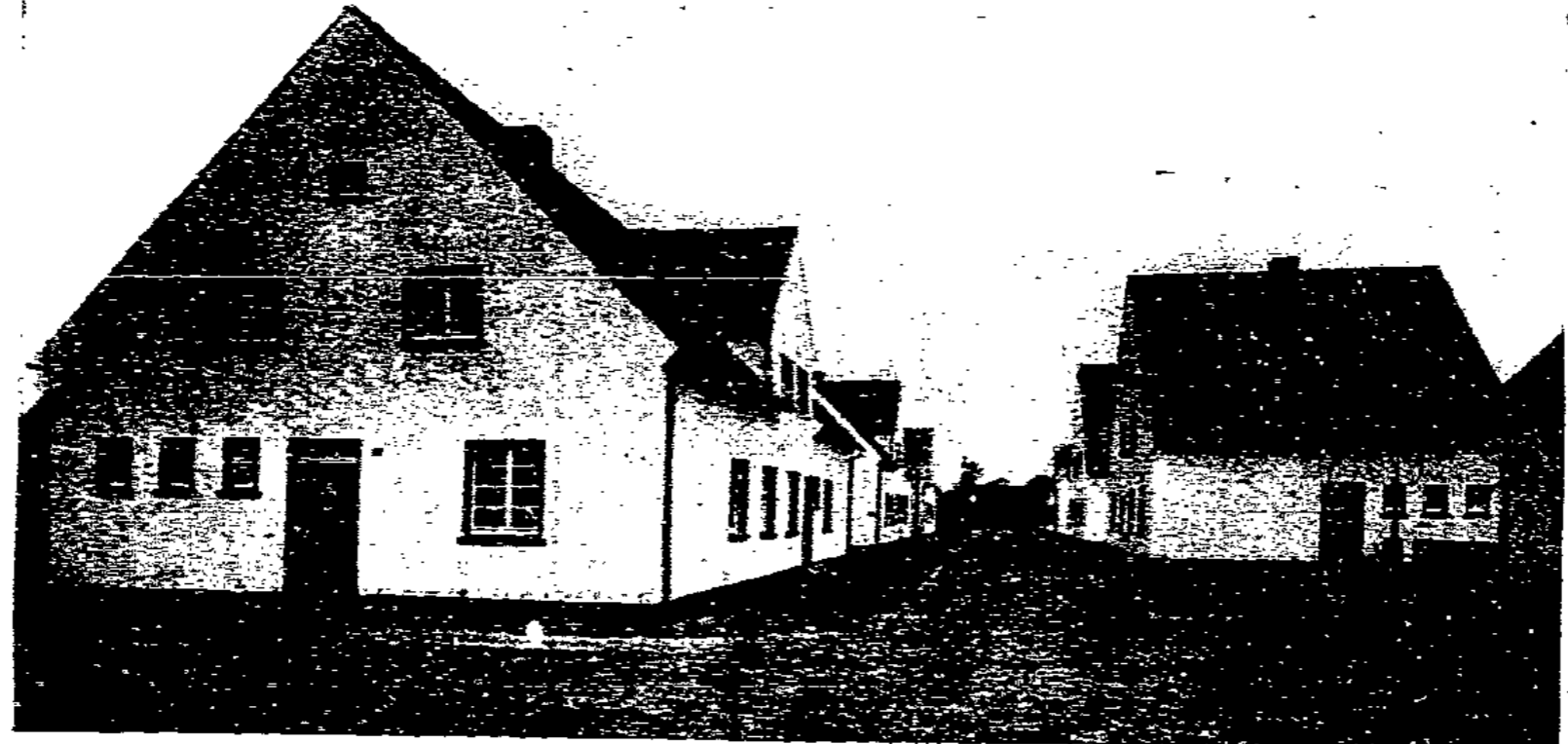
Auftraggeber der Siedlung: Stadt Düsseldorf. Ausgeführt von der Baugesellschaft Düsseldorf e. G. m. b. H., Düsseldorf.
