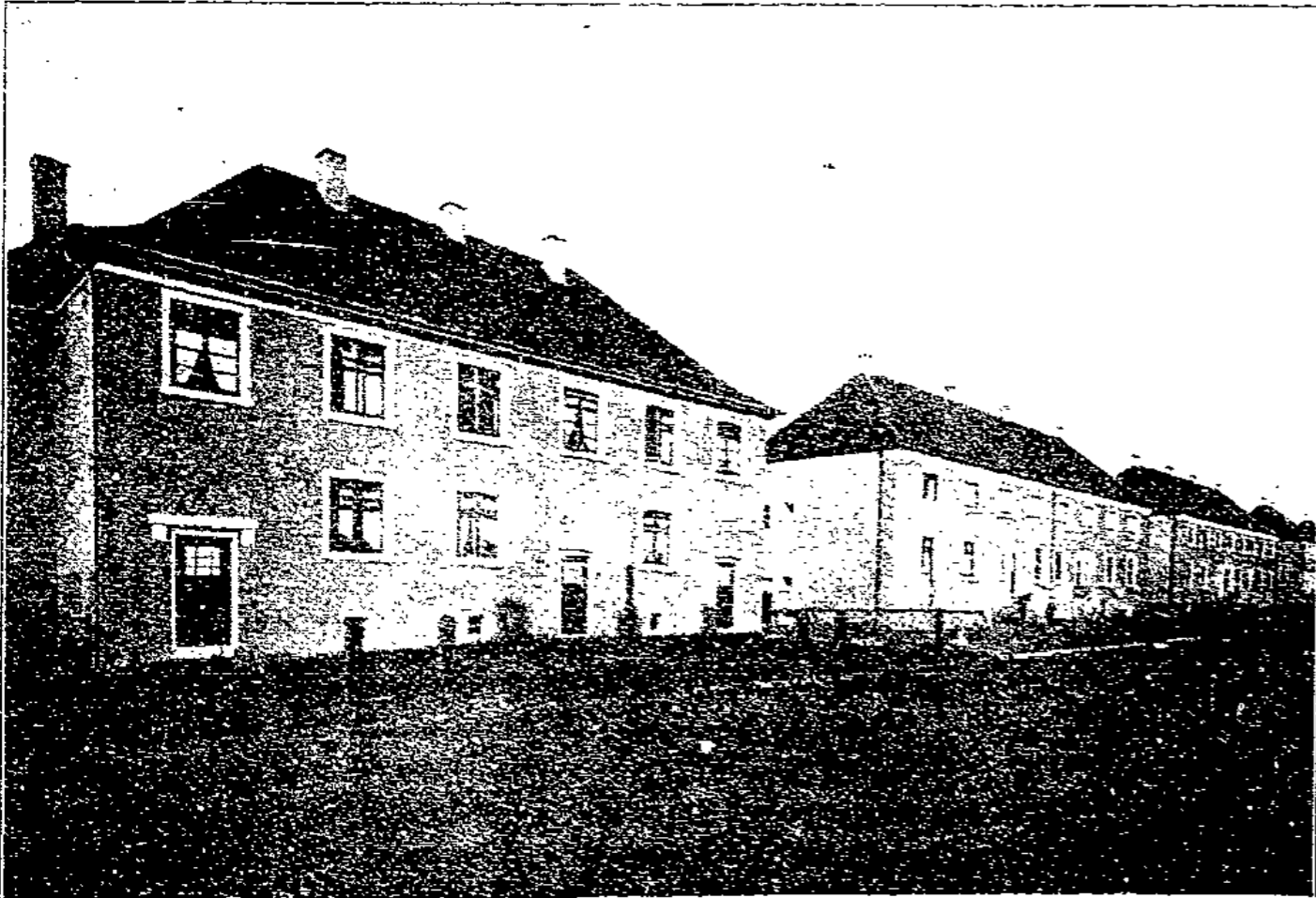
Bergmannsiedlung Harlinghauser Knappschaft, Hamm i. W. Ausführung: Bauproduktiv-Genossenschaft „Gemeinwohl“ e. G. m. b. H., Hamm i. W.
