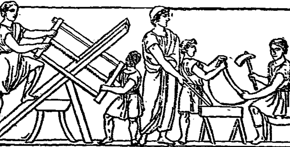
Abb. 9. Griechische Zimmerleute bei der Arbeit
