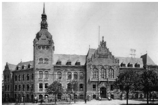
Verwaltungsgebäude von Bergbau-Verein und Zechen-Verband in Essen
