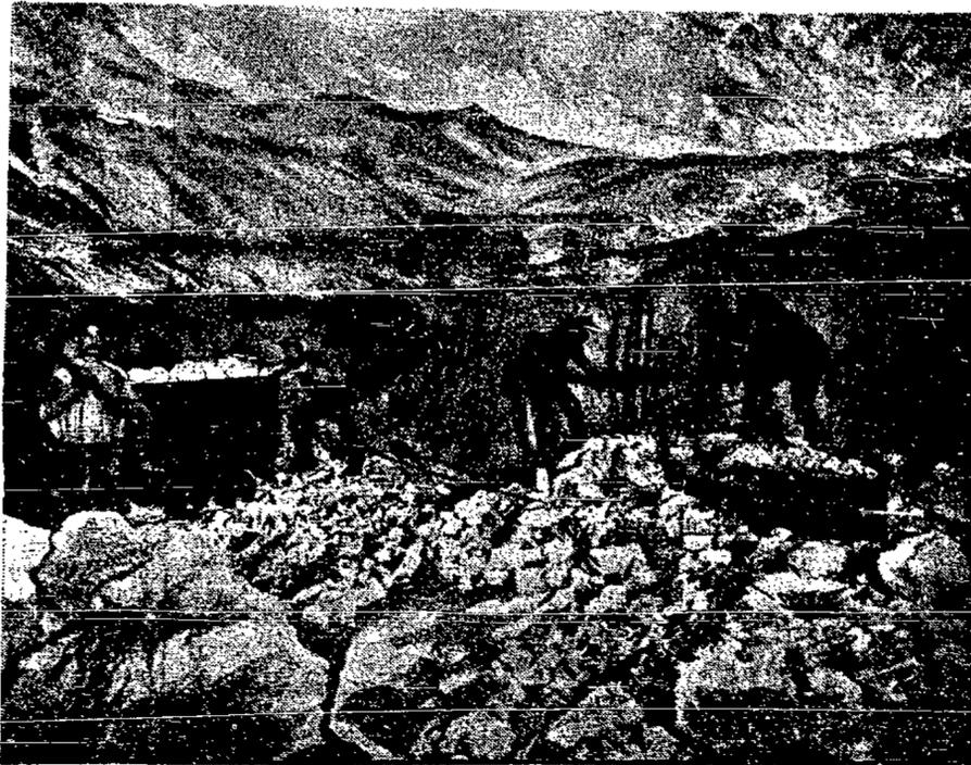
Abbau von Salzen mit Hilfe elektrischer Bohrer
