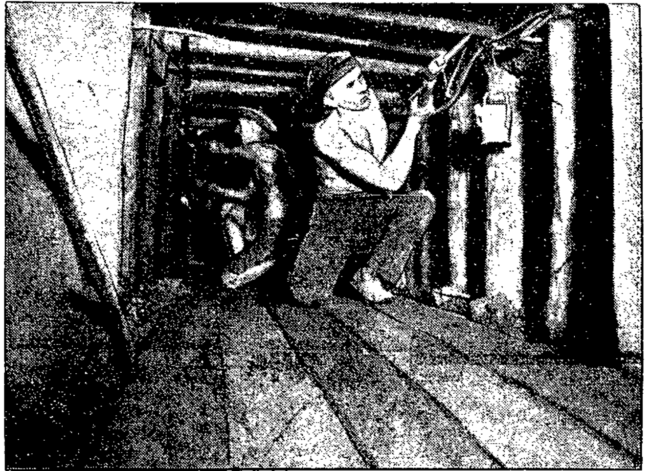
Ein Bild von den schwierigen Rettungsarbeiten in der Unglücksgrube.
