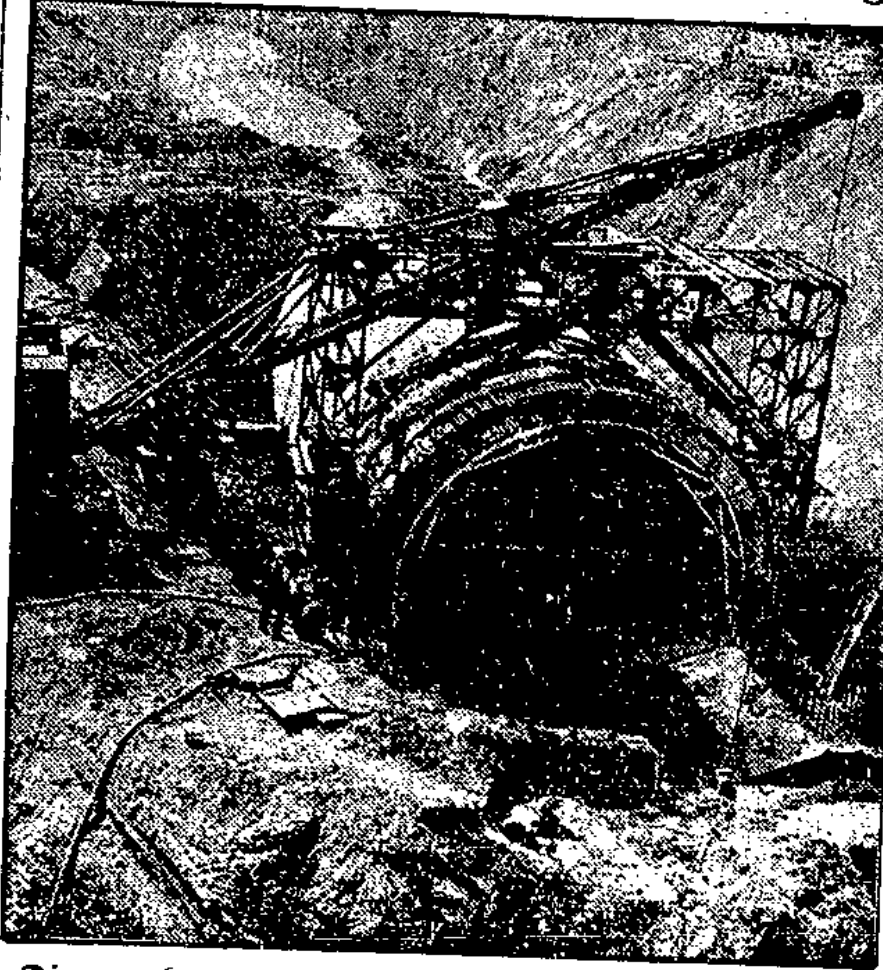
Die ungeheure Betonröhre, in die der Fluß Des Peres (U.S.A.) abgeleitet werden soll, im Bau.
