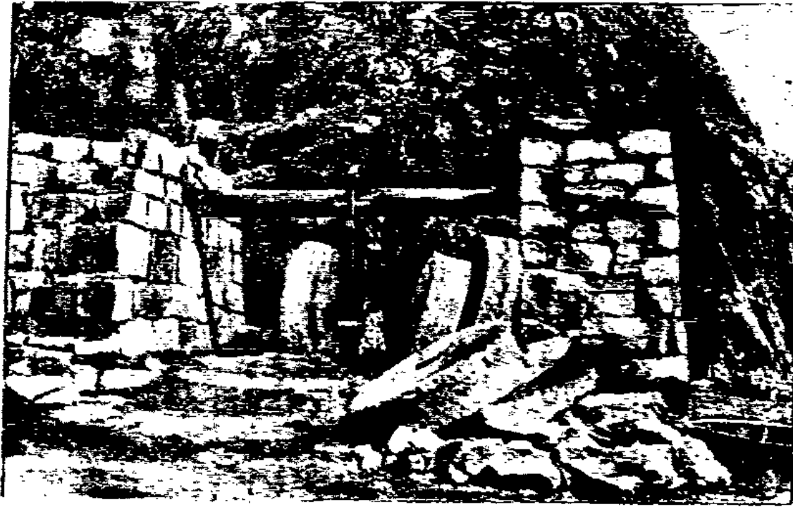
Primitive Silbermine im Hochgebirge von Peru, wo das erzführende Gestein mit Hilfe schwerer, senkrecht stehender Mühlräder grob zerkleinert wird. Die Achse, neben der die riesigen zwei Meter hohen Mühlräder bewegt werden, wird unterirdisch durch Wasserkraft angetrieben.
