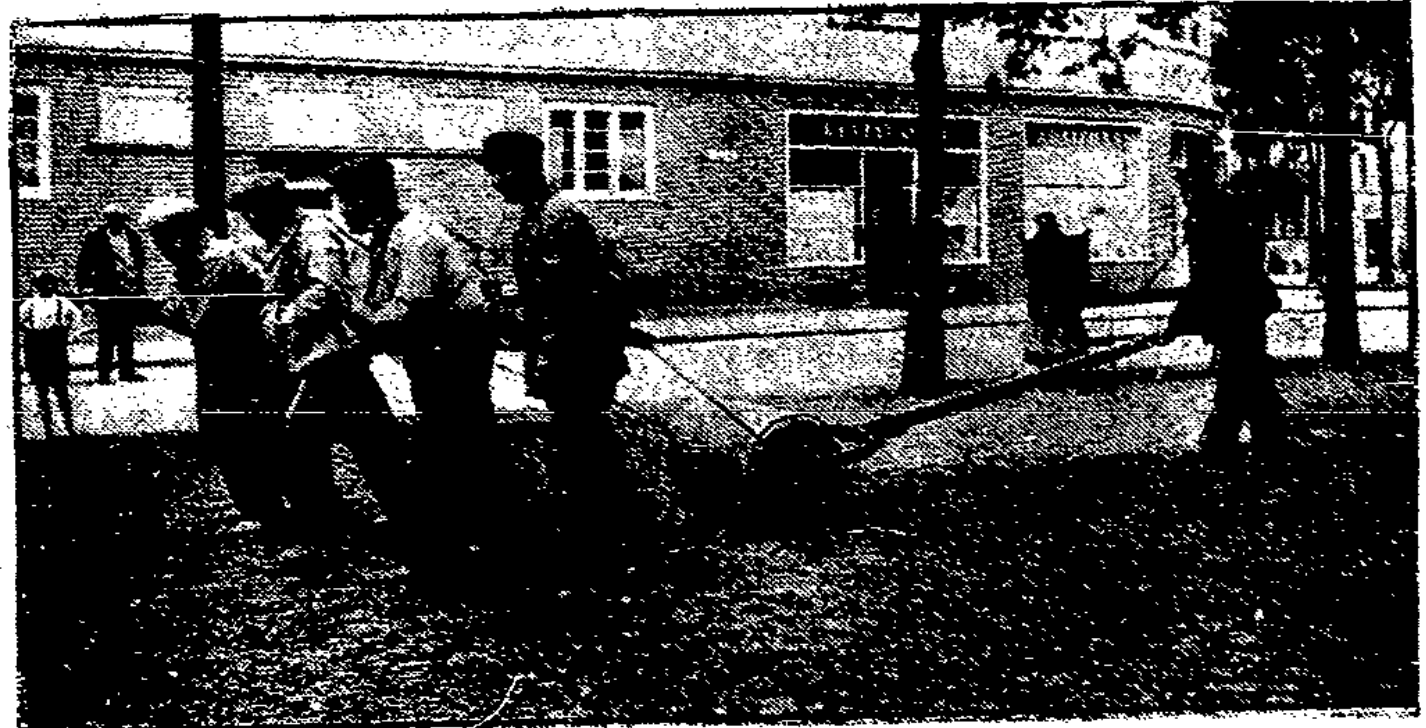
Die Pflanzwege in der Strandgasse werden gewalzt
