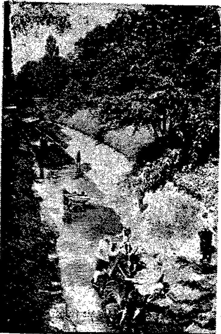
Wie alljährlich, wird der Radaunekanal auch in diesem Jahre um die Junizeit einer Generalreinigung unterzogen. Unser Bild zeigt die Arbeiten bei Petershagen.
