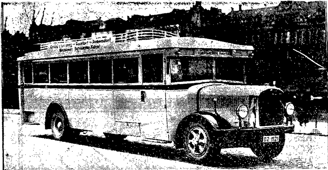
Einer der neuen 50plätzigen Saurer-Wagen mit Schwerölmotor.
