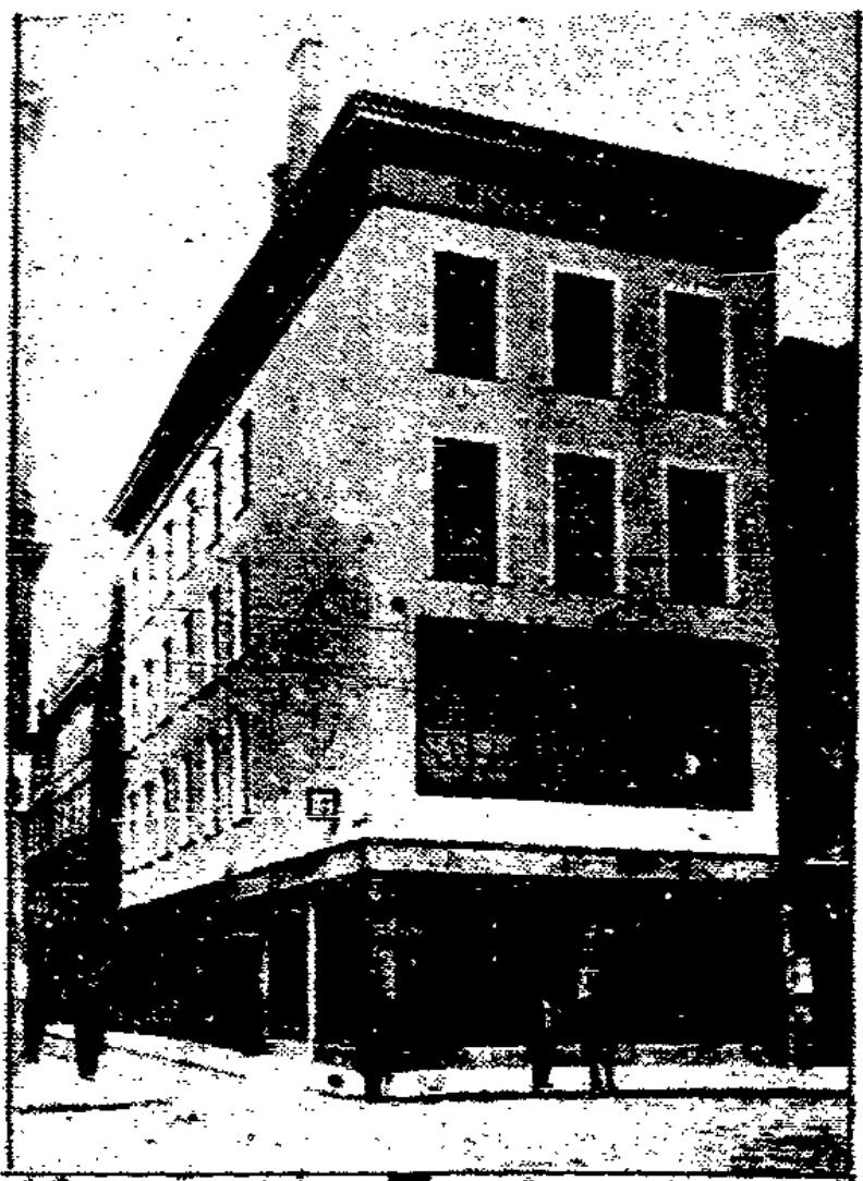
haus umgebaut worden. Unser Bild zeigt die veränderte Front.
