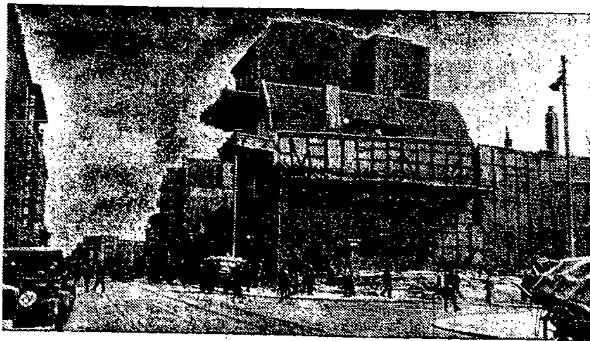
Es wird aufgeräumt Abbruchsarbeiten in Alt-Hamburg.
