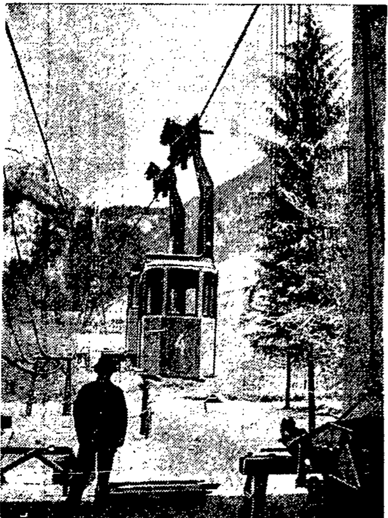
geht ihrer Vollendung entgegen. Die Bahn führt von Oberstdorf (Allgäu) nach dem Nebelhorn und überwindet einen Höhenunterschied von 1200 Meter. Wird von der Talstation in Oberstdorf auf den ersten Teil der Bahnstrecke.
