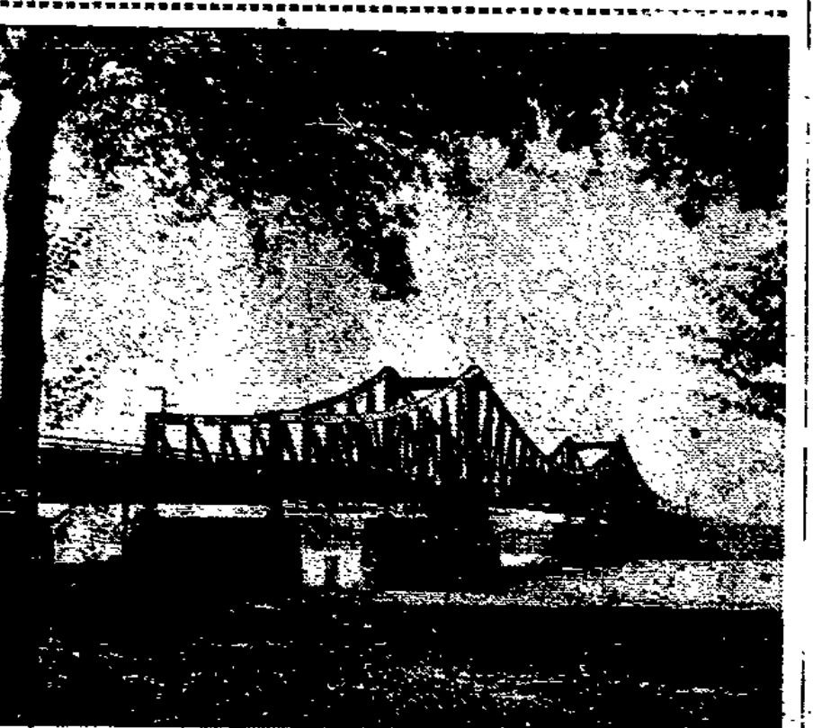
Die neue Rheinbrücke Düsseldorf — Neu wird dieser Tage dem Verkehr übergeben
