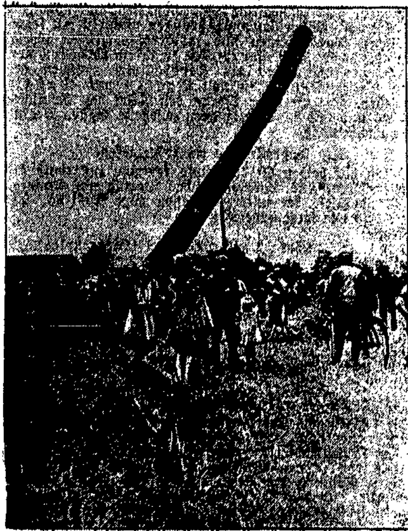
Der Schornstein wird umgelegt
